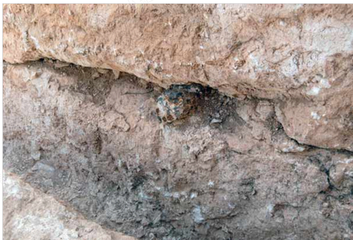
圖 21：A 區，分離溝槽內的楔子。
